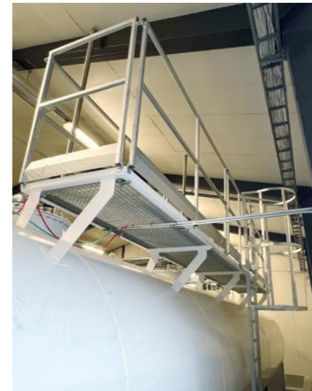
Huoltotasot lisäävät säiliöiden käytettävyyttä ja turvallisuutta.
