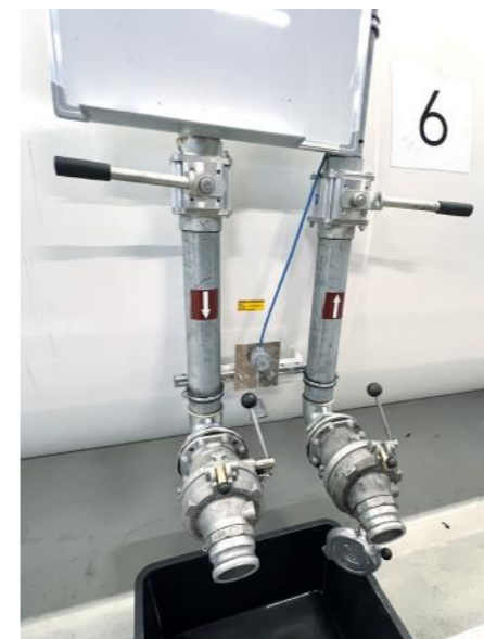
Molemmissa säiliöissä on kolme noin 23 kuution lohkoa varustettuna eri polttoainelaaduille täyttö- ja imuliitteillä (3")
