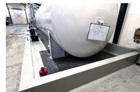
Säiliöt asennettiin lämpimään sisätilaan ja niiden alle valettiin betonista noin 25 kuution valuma-altaat mitkä epoksimaalattiin.
