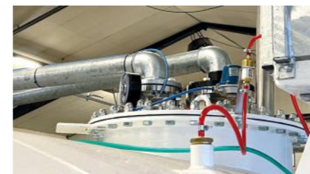
Kaksoisvaippaisissa säiliöissä on pintavahdit sekä alipaineistetun välitilan vuotohälytys GSM-liittymän kautta.
