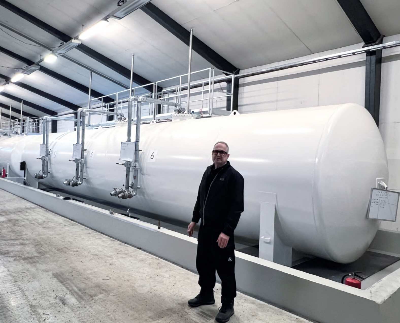
- Infraline on toimittanut työmaiden polttoainehuoltoon erikoistuneen Tankkauspartion Vantaan toimipaikkaan 140 000 litran säiliökokonaisuuden, esittelee Infralinen Jukka Rantamäki.
